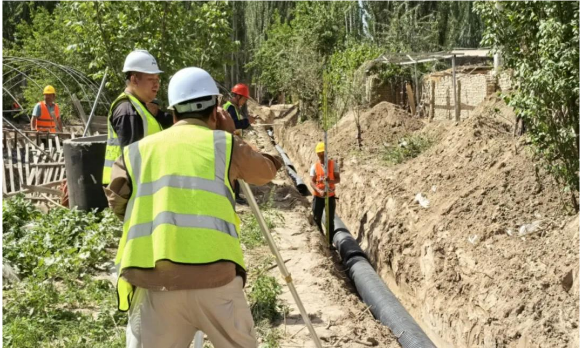
附件五：现场勘察照片
